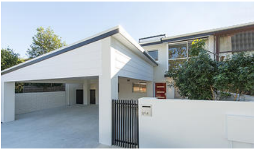
2, 14 Alston Avenue, Como
